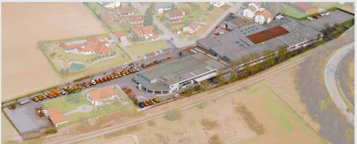
Luftaufnahme vom Betriebsgelände mit Verwaltung und Produktion
