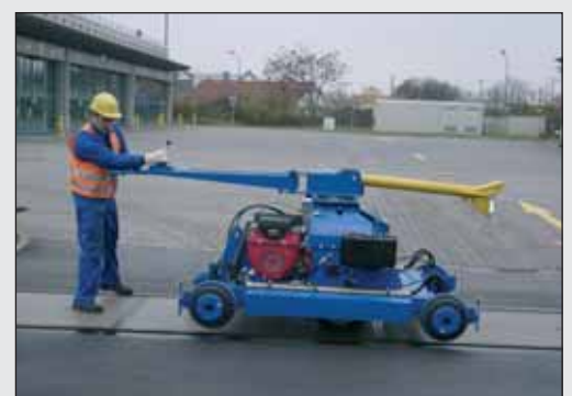
Aufgleisen im niveaubenen Bereich
